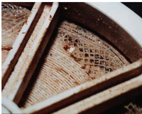
图 9-10 生物污堵所致高压差将流道网格冲出
